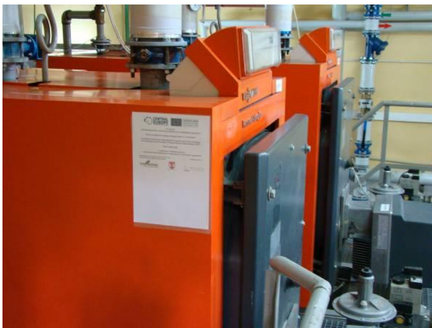
Zdjęcie nr 2. Piece grzewcze w Zespole Szkół nr 1 w Gorlicach Źródło: 3.4.9 Pilot Investment Report Pilot Project in Gorlice District
