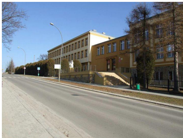
Zdjęcie nr 1: Budynek Zespołu Szkół nr 1 szkoły przy ulicy Wyszyńskiego 18 w Gorlicach
